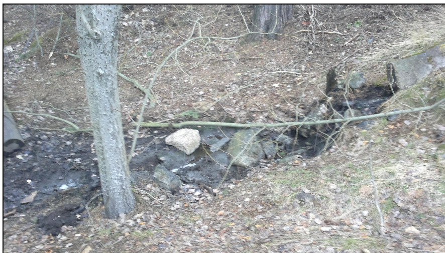
Kuva 6. Maijalan alapuolella olevan hulevesiviemäriin purkupaää.
